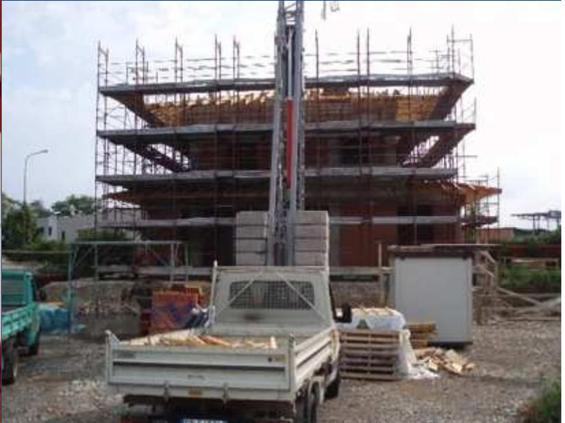
**MURATURE PERIMETRALI** : comunemente si fanno in muratura di laterizio e successivo cappotto, noi invece usiamo murature preformate in polistirene all' interno delle quali coliamo calcestruzzo: la struttura e' antisismica , in uno spessore minore si ottiene molto più isolamento termico e anche acustico, ( il 60% della muratura e' composto da materiale isolante)
